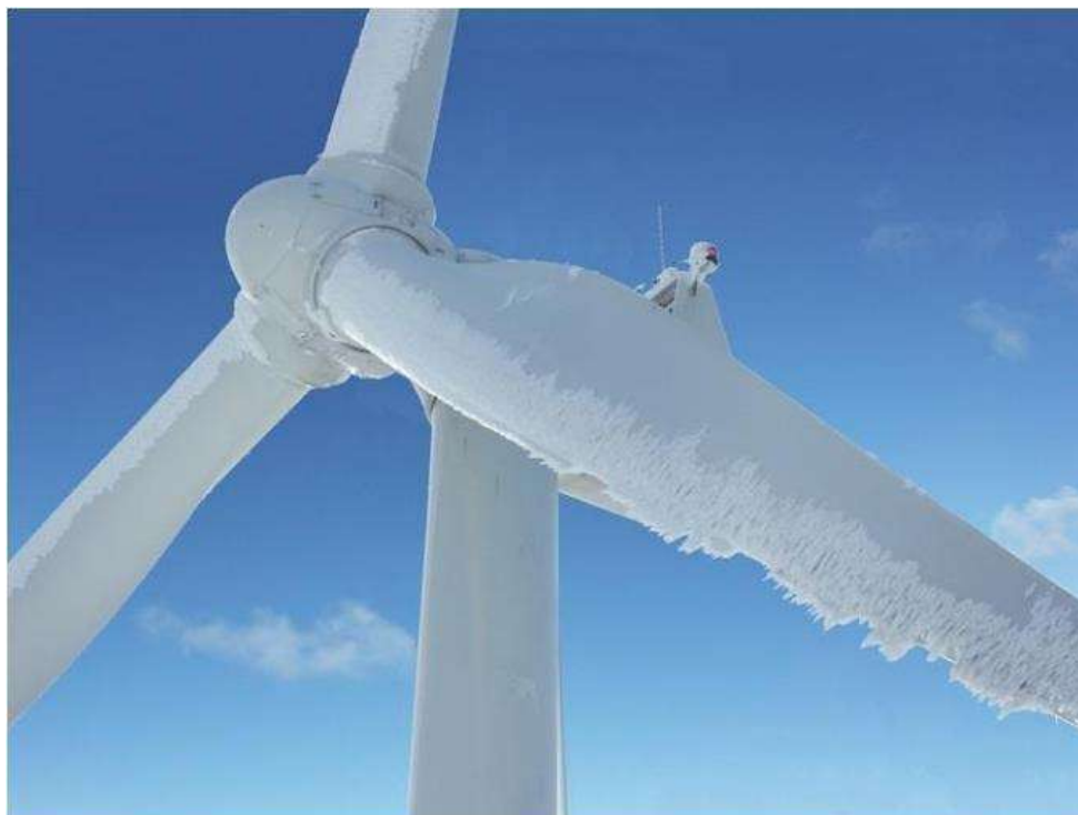
Рис. 7.2. Приклад обледеніння лопатей
